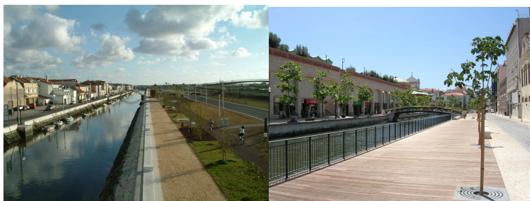
Figura 4.53 – Canal de S. Roque e Canal do Cojo (2007).
