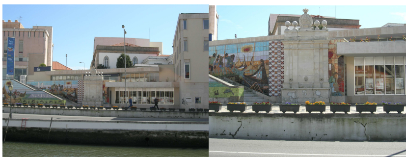
Figura 4.14 – Nova "Fonte dos Arcos" (2007).
