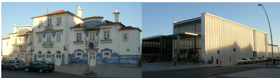
Figura 4.58 – Edifício da Estação de Aveiro (antigo e novo).
