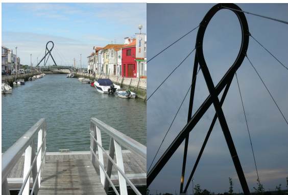
Figura 4.55 – Nova ponte sobre o Canal de S. Roque e Canal dos Botirões (2007).
