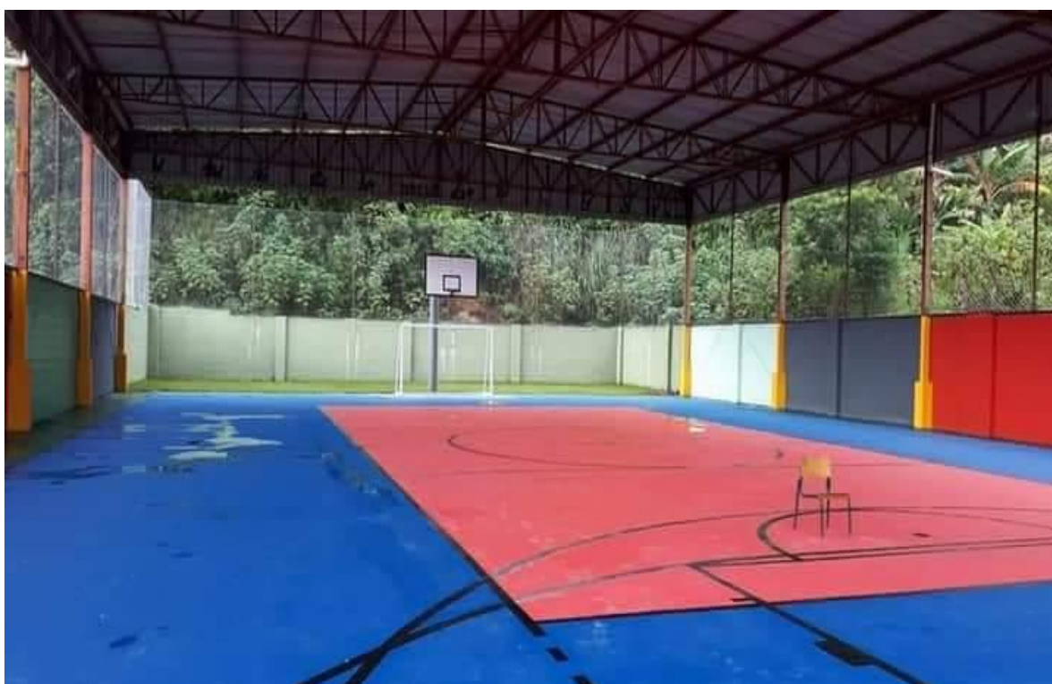
Foto 7 – Quadra de esportes depois da limpeza e pintura.
