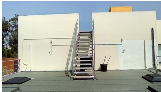
Figura 5.6 – Parede adjacente à área útil considerada para implementação do sistema PV.
