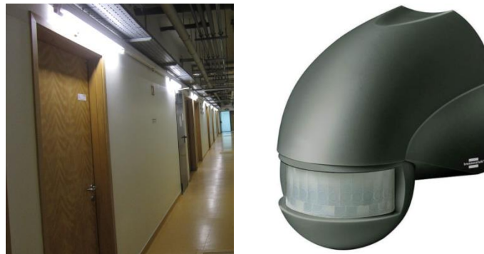
Figura 5.2 – Iluminação de zonas de circulação à esquerda e detetor proposto para a medida de sistema de controlo da mesma.
