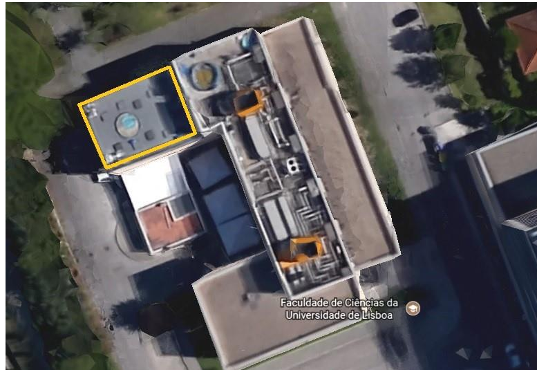
Figura 5.4 - Vista superior da cobertura do edifício. A zona delimitada a amarelo corresponde à área viável para instalação do sistema. Fonte: Google Earth .
