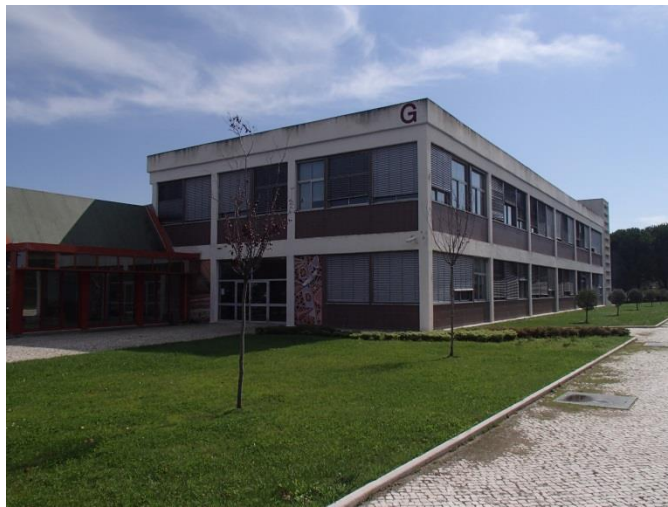
Figura 20: Edifício G: Instalações do Departamento de Energias Renováveis
