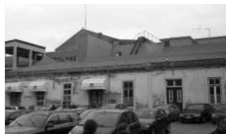
Figura 45. Vista da construção adjacente ao Hospital do Desterro e da sua cobertura junto à entrada da Rua Nova do Desterro
