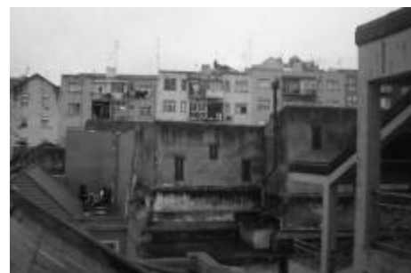
Figura 44. Vista da construção no interior do quarteirão e das fachadas traseiras dos edifícios adjacentes à Rua Capitão Renato Baptista
