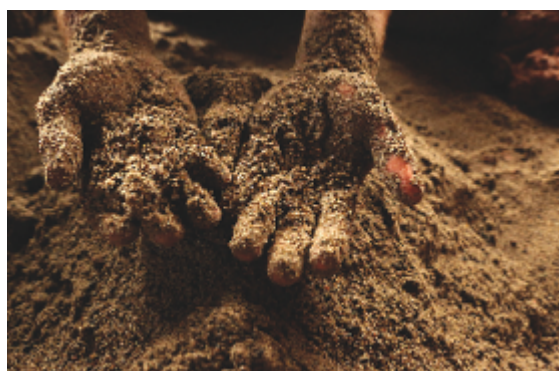
5 – A partir daqui, utiliza-se apenas as mãos. Depois de amassada a argila, junta-se o granel e areia à mesma. Fonte: Fotografia de Felipe da Palma
