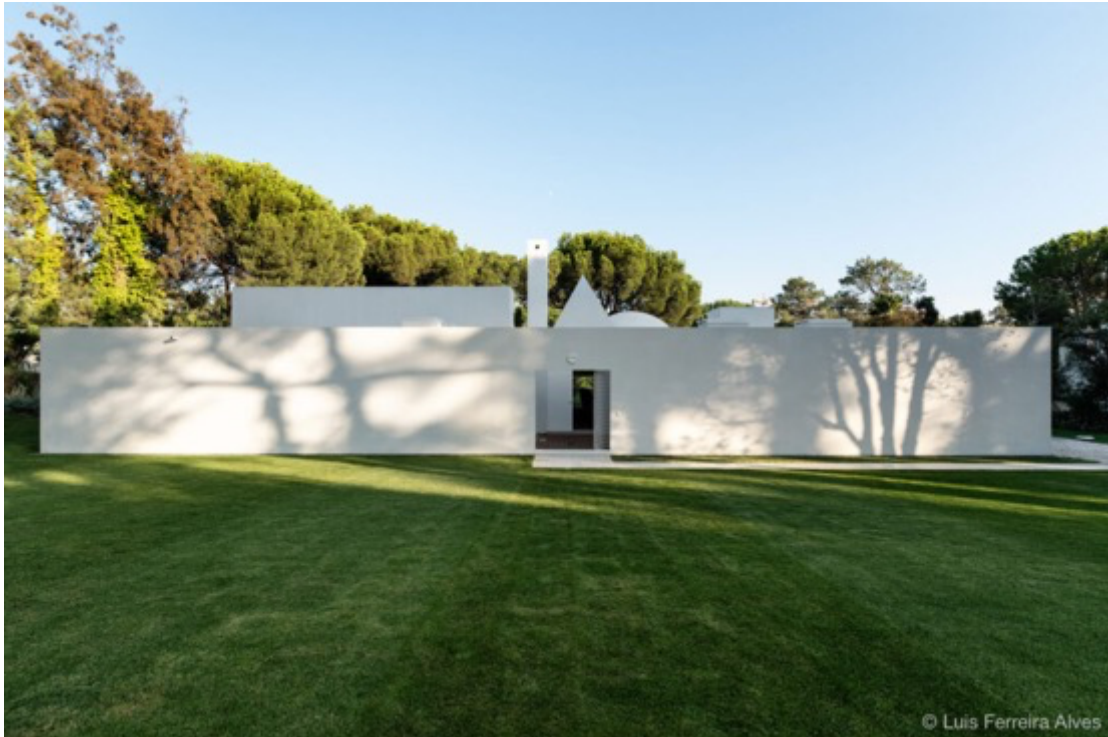
Figura 63– Casa Estalagem da cegonha, Quinta do Lago
