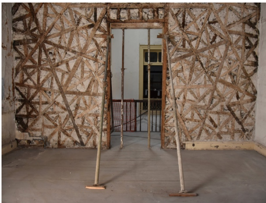
Figura 11 - Parede “Gaiola Pombalina”, Técnica de tabique, técnica de aplicação de terra sobre fasquiado em madeira. Localizada no centro histórico de São Pedro, Funchal.
