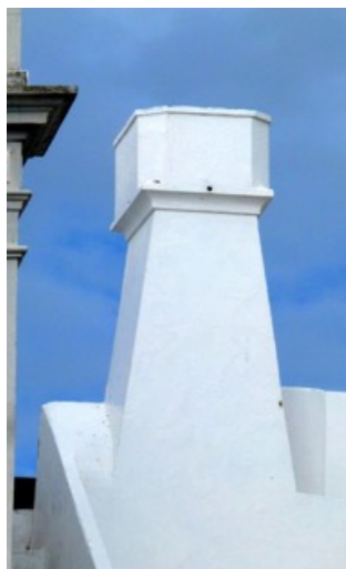
Figura 23 - Chaminé de balão de saia Olhão
