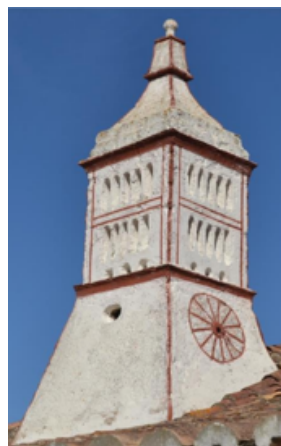
Figura 23 - Chaminé monumental de ladrilho simples, Porches.
