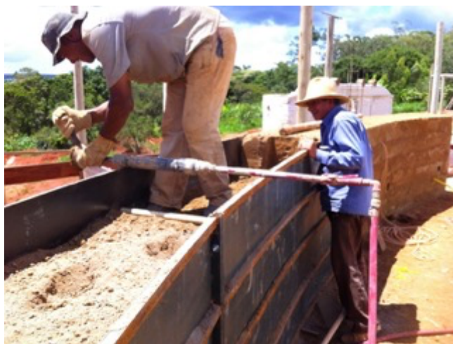
Figura 13 - Execução de parede em alvenaria de taipa Fonte: Website Materiais e técnicas para construção sustentável
