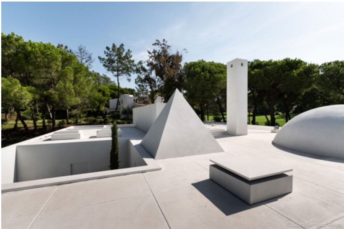
Figura 64 – Casa Estalagem da cegonha, Quinta do Lago
