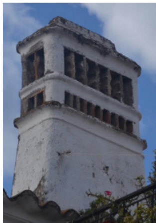
Figura 23 - Chaminé de planta retangular com grelha de ladrilho, Paderne.
