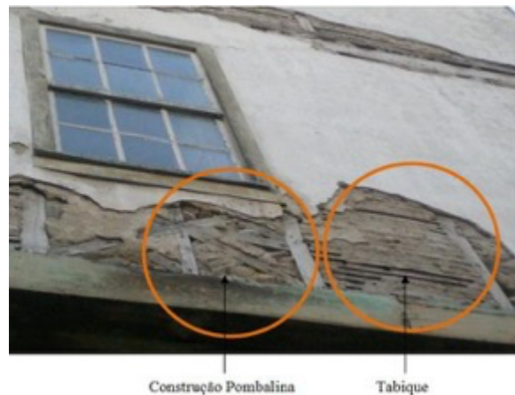
Figura 10 - Parede de tabique de um edifício multifamiliar; localizada na freguesia de Santa Maria Maior, Chaves.
