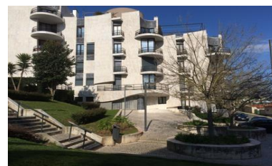
Fig. 35 - Rua dos Quartéis
