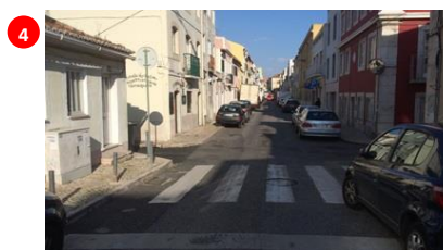
Fig. 67 - Rua do Embaixador (vista)
