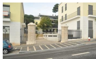
Fig. 47 - Vista para interior do condomínio
