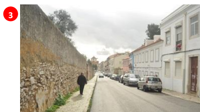
Fig. 66 - Rua Alexandre de Sá Pinto (vista)
