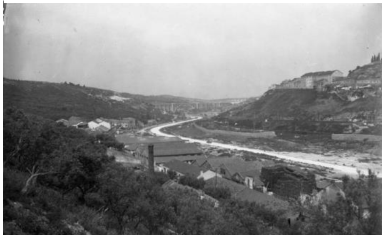
Figura 5- Construção da Avenida de Ceuta. Fonte: Arquivo Municipal de Lisboa
