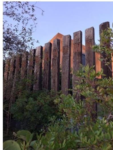
Figura 64 –Aplicação das sulipas de madeira na vedação do lote, em Torres Vedras. Autoria: Própria
