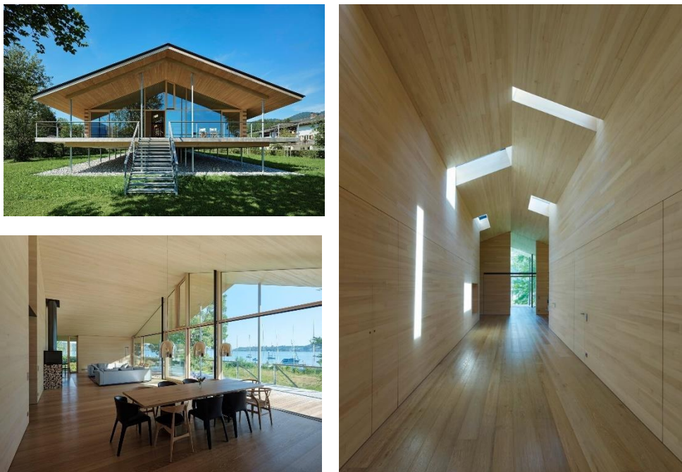
Figura 69,70 e 71– Materialidade pretendida com a utilização do CLT. Projeto Lakeside House, na Alemanha.
