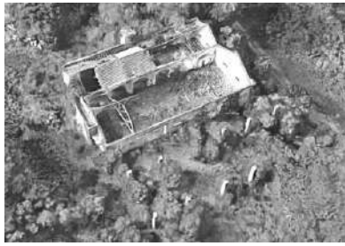
Figura 5. 21 - Ruínas da pedra (Google Earth)
