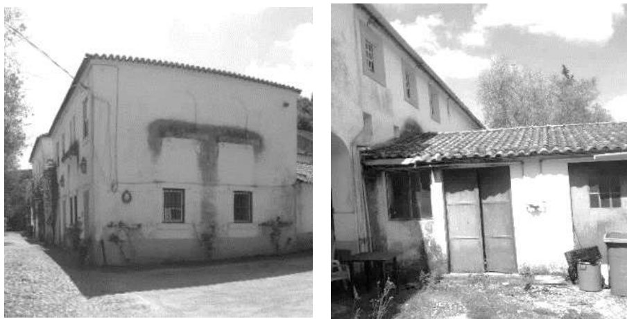
Figura 5. 20 – Vistas do exterior do conjunto de edifícios da casa agrícola
