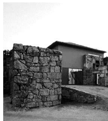
Figura 2. 6 - Paço de Pombeiro após reabilitação (Archdaily 2008)
