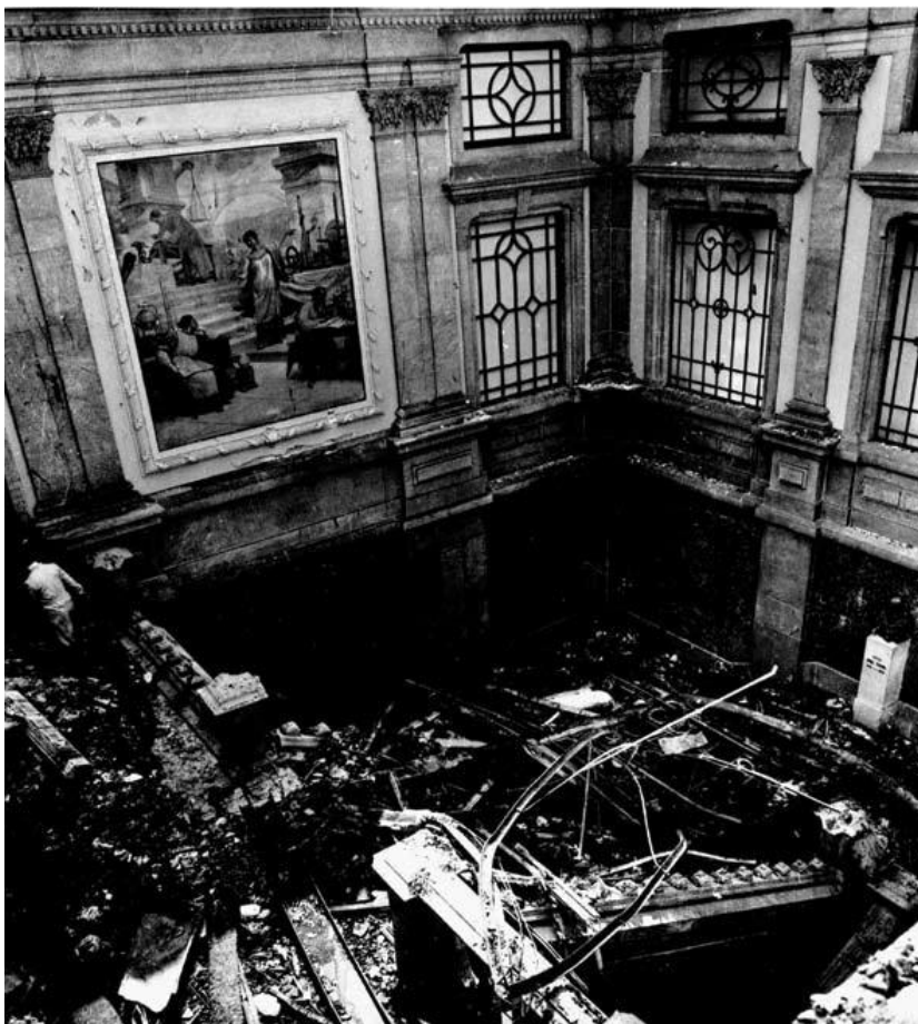
Ilustração 69: Escadaria nobre do edifício da Praça Gomes Teixeira, após forte incêndio em Abril de 1974. Na parede vimos um dos três frescos de Salgado Veloso neste edifício, tendo sido um totalmente destruído. (Arquivo Digital da Universidade do Porto).
