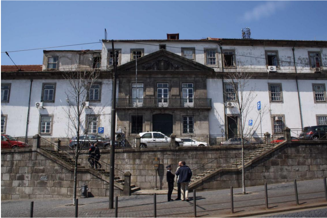
Ilustração 14: Fachada principal do antigo edifício da Real Casa Pia e do Governo Civil do Porto, actualmente pertence à GNR. (Fotografia de 2007).
