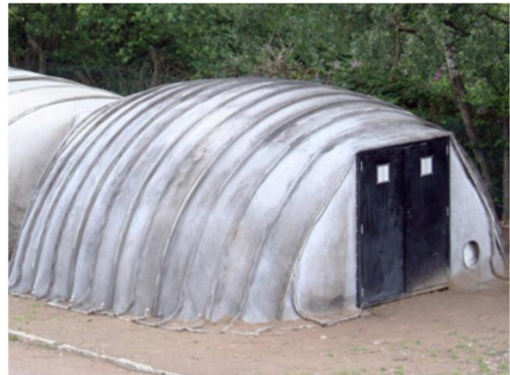
figura 119 | abrigos feitos com o tecido concreto fonte: Dezeen - architecture and design magazine
