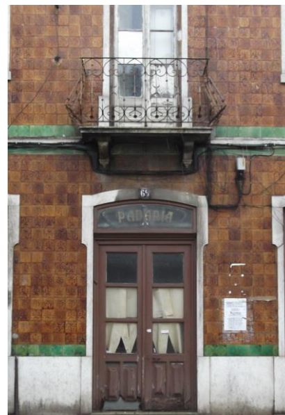
Fig. 35 – Caixilharia existente no alçado principal do edifício.
