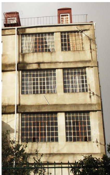
Fig. 37 – Pormenor da fachada tardo, com as marquises originais do edifício
