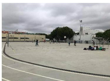
Espaço 4 - Exterior nascente
