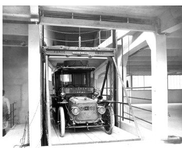
Fig. 6.13. Aspecto interior da garagem (in FP). Note-se as infra-estruturas eléctricas sobre a viga em primeiro plano e a plataforma hidráulica para deslocação vertical dos automóveis.
