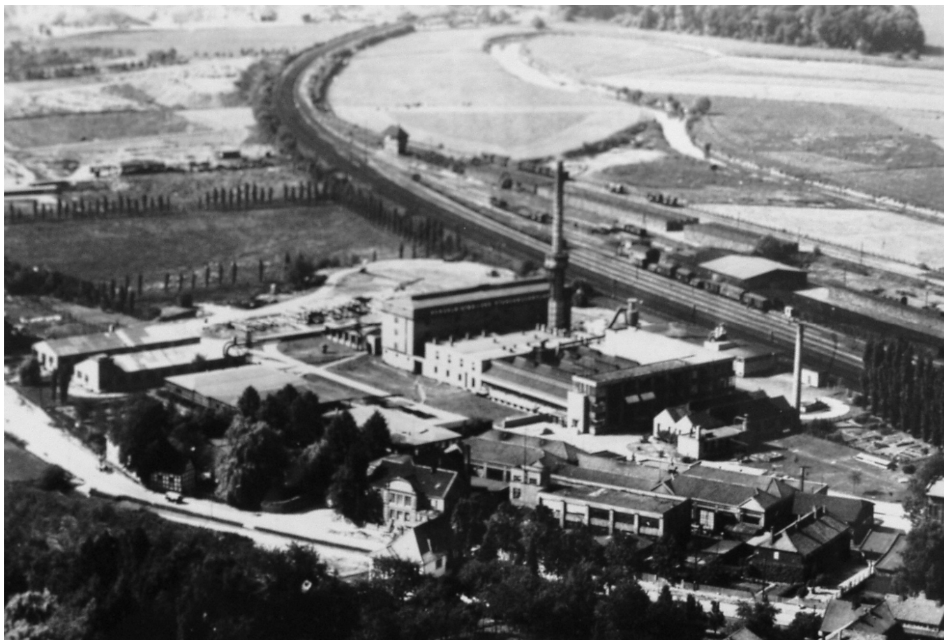
Fig. 6.35. Vista do complexo fabril da Fagus em 1959. Fotografia de Westdeutscher Luftfoto, Bremen (in AB).
