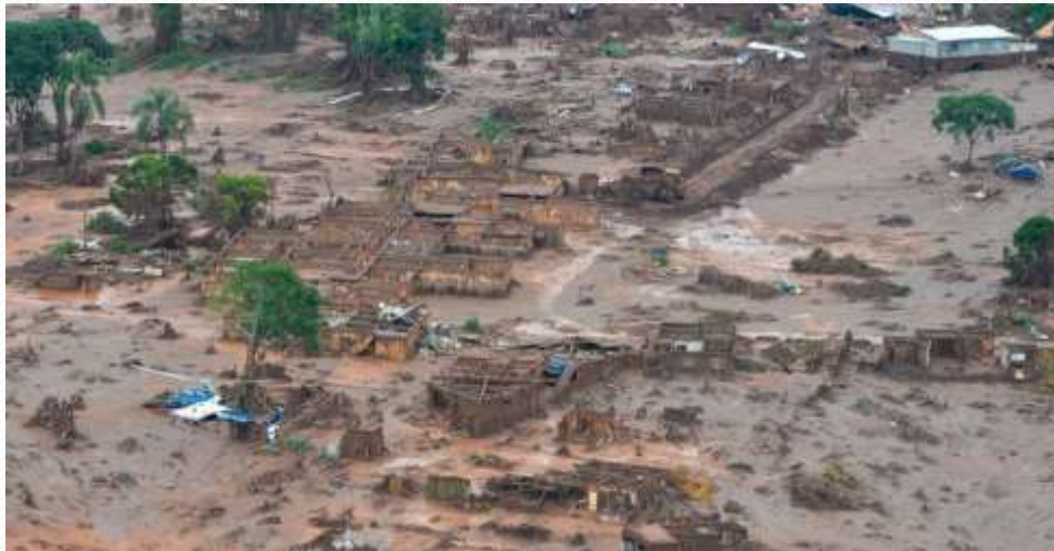
Fig.17- Barragem do Fundão (retirado de https://www.revistaforum.com.br/apos-3-anos-de-rompimento-de-barragem-moradores-de-distrito-de-mariana-estao-proibidos-de-voltar-para-casa/ )
