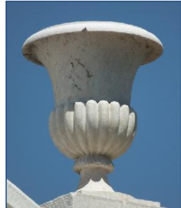
Fig. 453, 454 – Edifício da primitiva estação do Caminho-de-ferro do Barreiro | exemplares em pedra lioz
