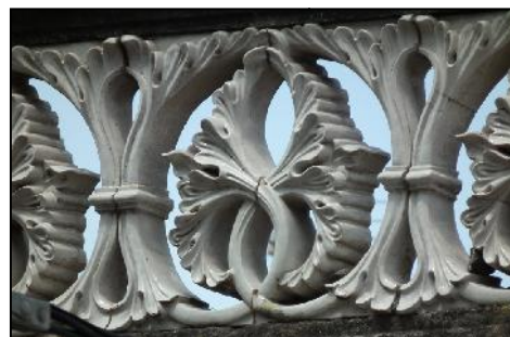
Fig. 381– Moita | Rua Silva Evaristo n.º 14 | vista geral do edifício | pormenor da balastrada com acantos estilizados
