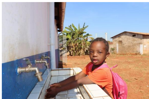
Fig. 40 Saneamento na Escola de Injovola. Fonte: UNICEF.
