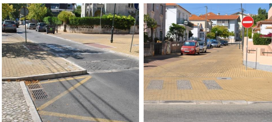
Fot. 17 e 18 Utilização de betão ou pavê na Rua D. Afonso de Albuquerque, S. Pedro do Estoril
