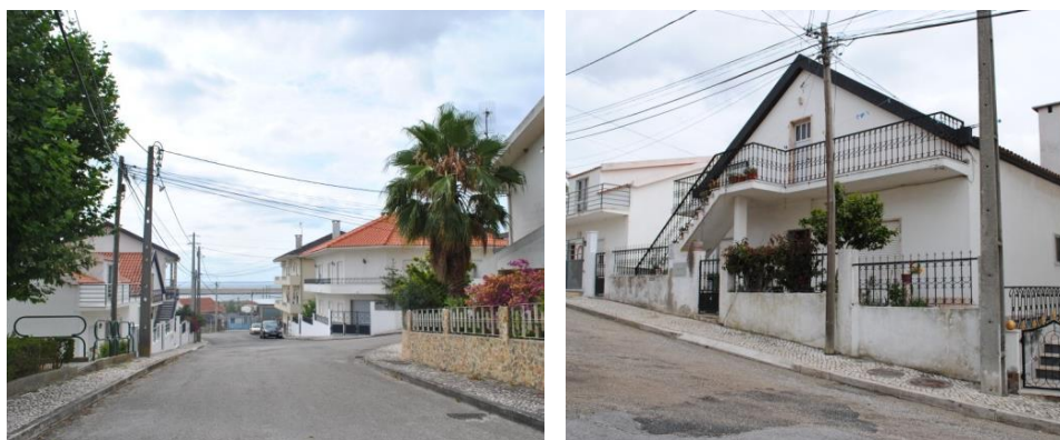
Fot. 42 e 43. Bairro dos Forninhos apresenta as deficiências comuns de degradação dos pavimentos dos arruamentos.
