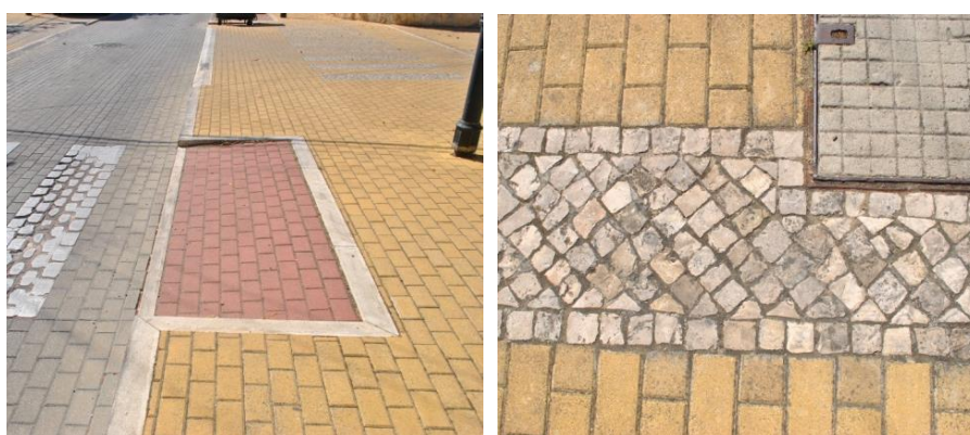
Fot. 21 e 22. Estereotomias e cores diferenciadas do material aplicado na Rua D. Afonso de Albuquerque, S. Pedro do Estoril
