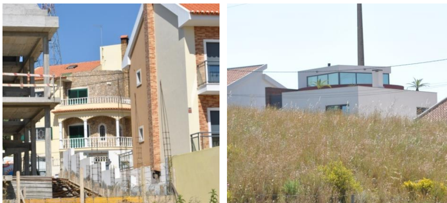
Fot. 9 e 10. Construção inacabada no Bairro de Primavera, Santa Iria de Azoia.
