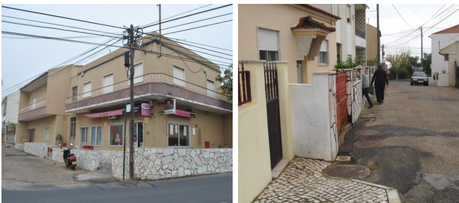
Fot. 35 e 36. Os arruamentos secundários carecem de sinalização de trânsito adequada. A intervenção neste bairro pode ter como referência a solução apresentada nas imagens n.º 8 a n.º 15.
