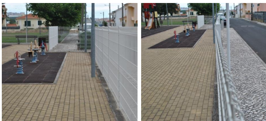
Fot. 15 e 16. Pavimentos (tartan; pavê, vidroço) no Largo do Bairro da Junqueira, Loures
