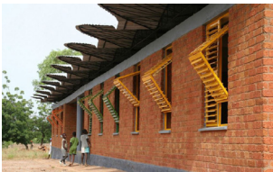
Fig. 33 Escola Primária, Diébédo Francis Kéré, Gando Burkina Faso, 2002
