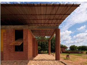
Fig. 32 Escola Primária, Diébédo Francis Kéré, Gando Burkina Faso, 2002
