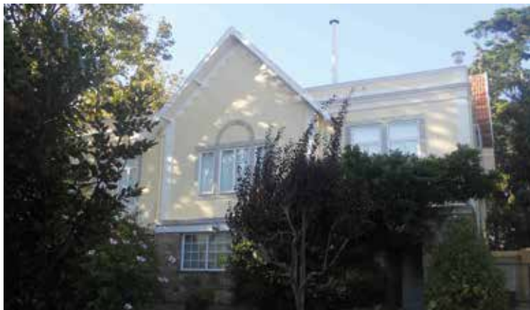
6. Fachada Sul da moradia para Albano Augusto Gourcelt [2011]
