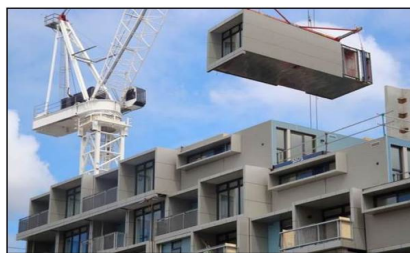
Figura 53 - Local de construção pré-fabricada.
