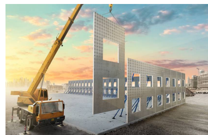
Figura 49 - Montagem de um sistema pré-fabricado.
