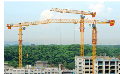
Figura 56 - Grua, equipamento de construção.
