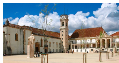
Figura 129 - Fotografia do Pátio e Paço das Escolas, Universidade de Coimbra.
