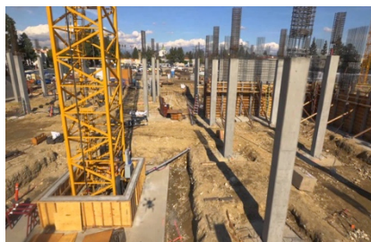
Figura 52 - Local de construção tradicional.
