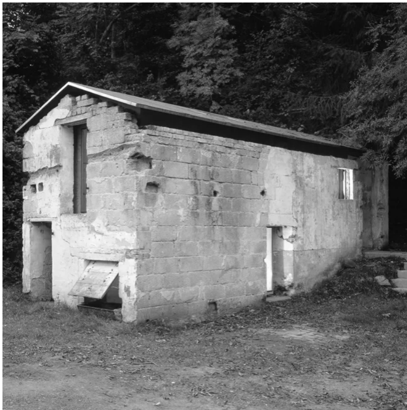
Figure 0.12 Vista perspética do edifício
