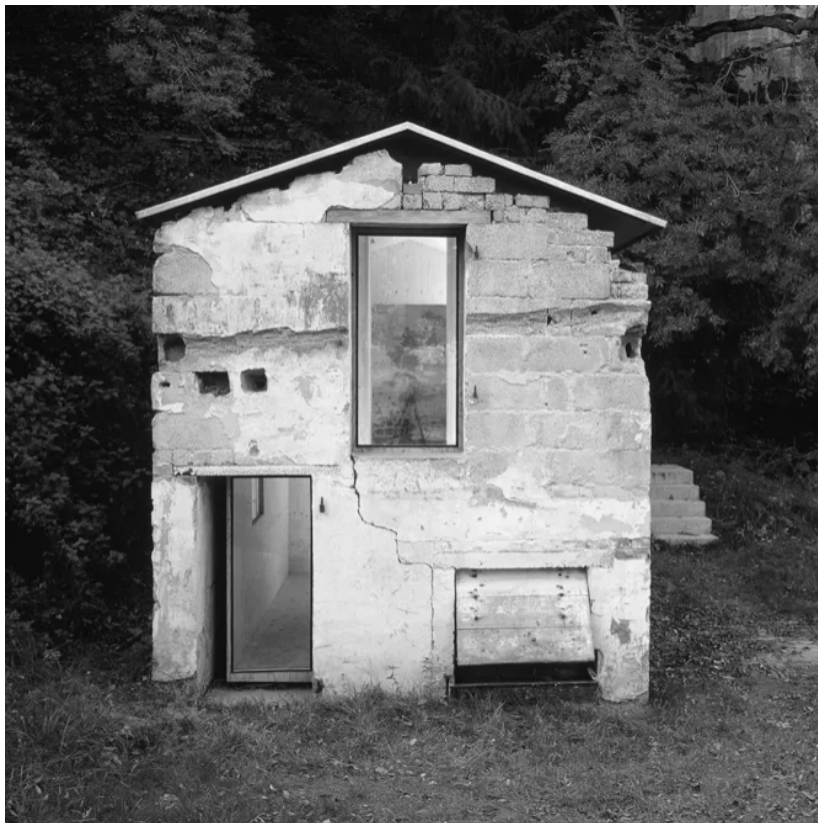
Figure 0.10 Vista do alçado frontal do edifício
