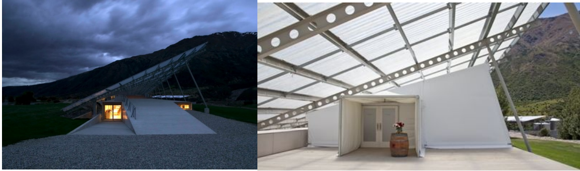
Figura 13 Estrutura de cobertura. Fonte - http://www.peregrinewines.co.nz/gallery.php
