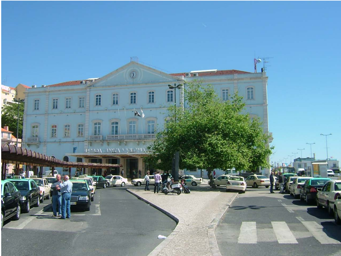
Foto nº4.vista do largo dos caminhos-de-ferro. Sentido Terreiro do Paço – Lisboa Oriente.
