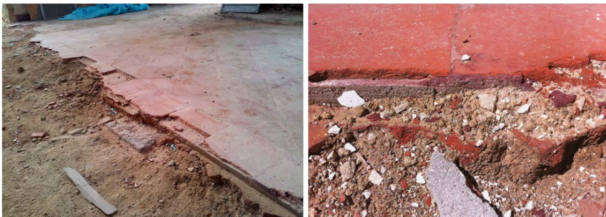
Figura 75 - Nestas imagens está visível a sobreposição de pavimentos numa das salas do palácio.
