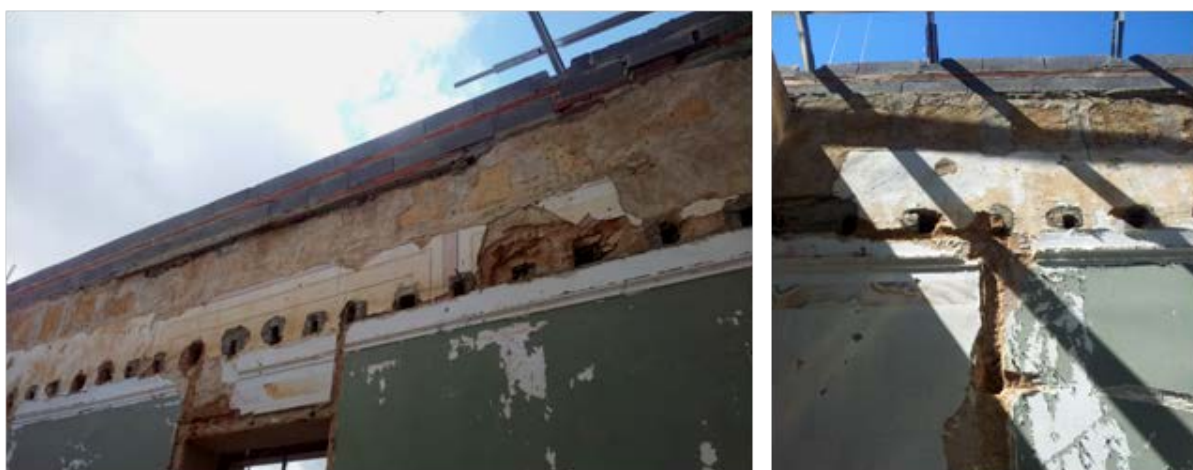
Figura 69 - Construção de uma cinta de blocos de betão enquanto elemento estrutural e de regularização para o assentamento da nova cobertura.
