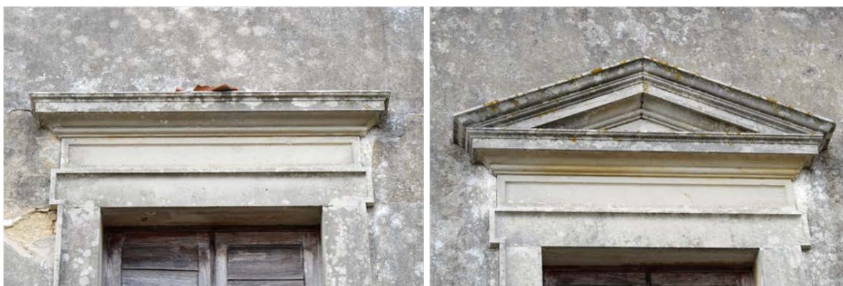
Figura 77 - Anomalias nos elementos de pedra calcária nos emolduramentos, frontões e vergas destacadas das janelas de sacada.
