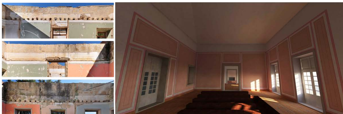
Figura 88 - As imagens retificadas das paredes que continham frescos, facilitaram a compreensão do seu padrão e métrica.
