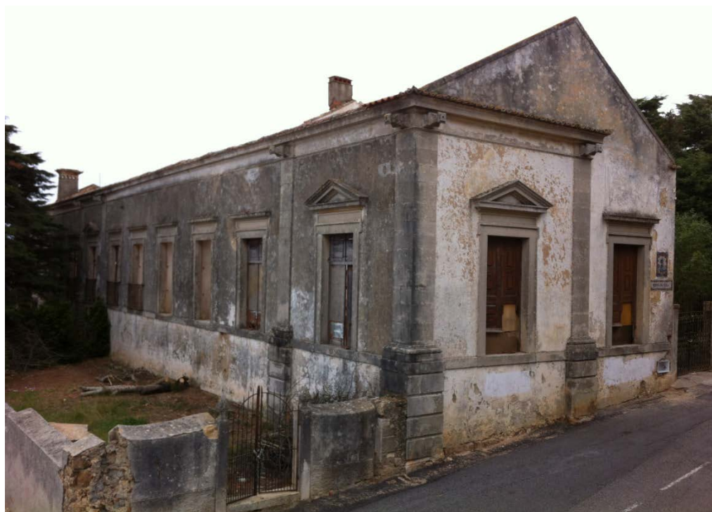
Figura 16- Palácio dos Marqueses de Ponte de Lima
