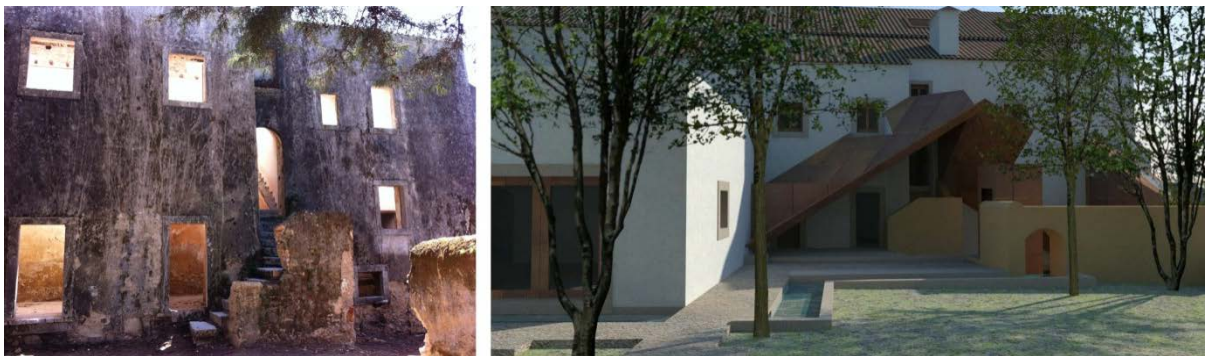
Figura 93 - O abrigo para o acesso vertical exterior, por escada e elevador, é de estrutura leve, pouco intrusiva e de possível remoção.
