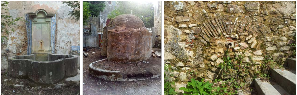
Figura 18 - Elementos no jardim do Palácio - Fonte revestida de azulejos (à esquerda), poço coberto (ao centro), fonte / bica (à direita)
