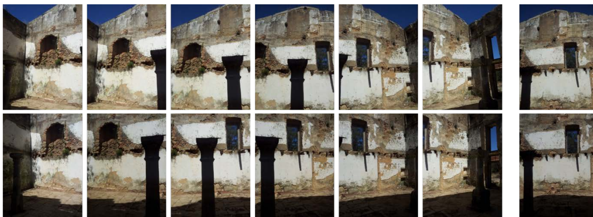
Figura 28 - Fotografias da fachada B.0.1.a adquiridas com recurso a máquina fotográfica de telemóvel.
