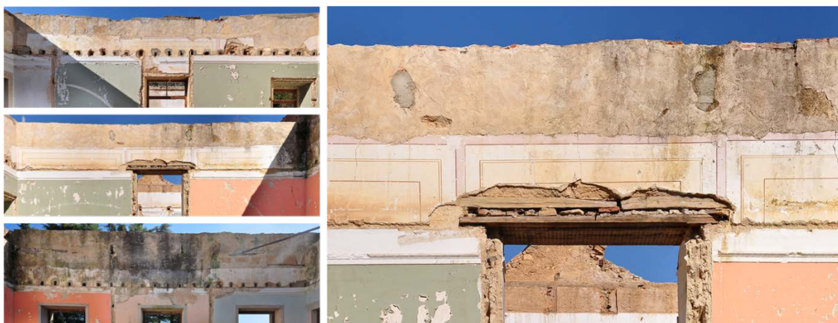
Figura 73 - A sobreposição de revestimentos resultante de várias ocupações sucessivas do edifício esconde os sinais do que poderão ter sido os frescos originais que revestiam as paredes do palácio.
