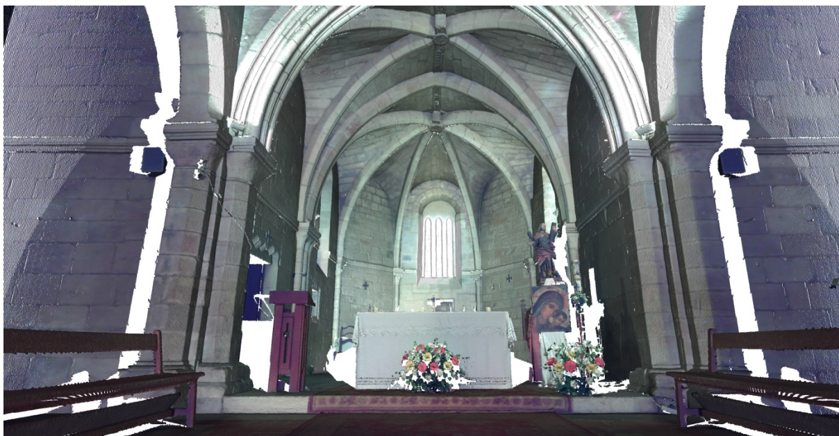
Figura 2 - Vista do modelo obtido por VL3DT referente ao interior da Igreja de Santo André, Mafra.
