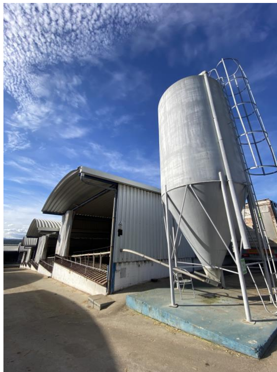
Figura 17 - Exemplificação do fornecimento do alimento de forma automática, com bombeamento direto dos silos
