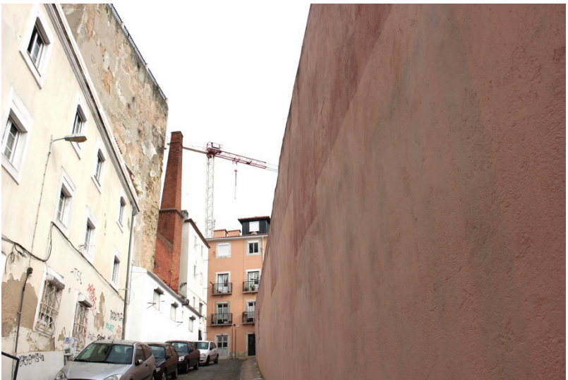
Fig. 15, 16 e 17 | Fotografias da envolvente, Calçada Nova do Colégio, Marisa Machado 2017
