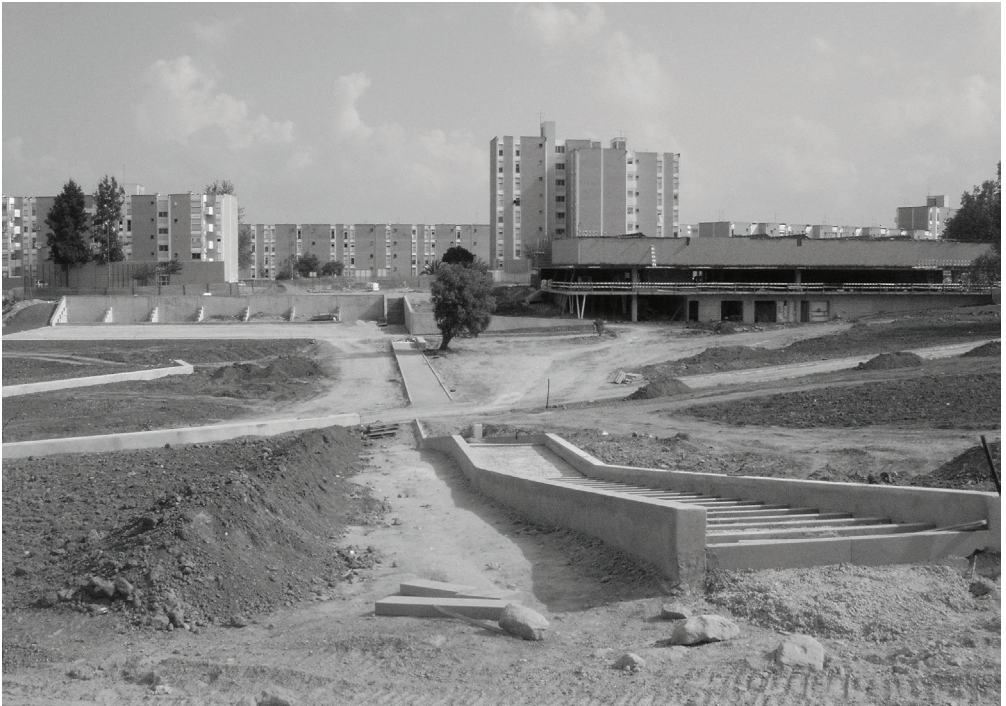
O Parque Urbano no Centro Cívico de Caparica em construção, 2011.
