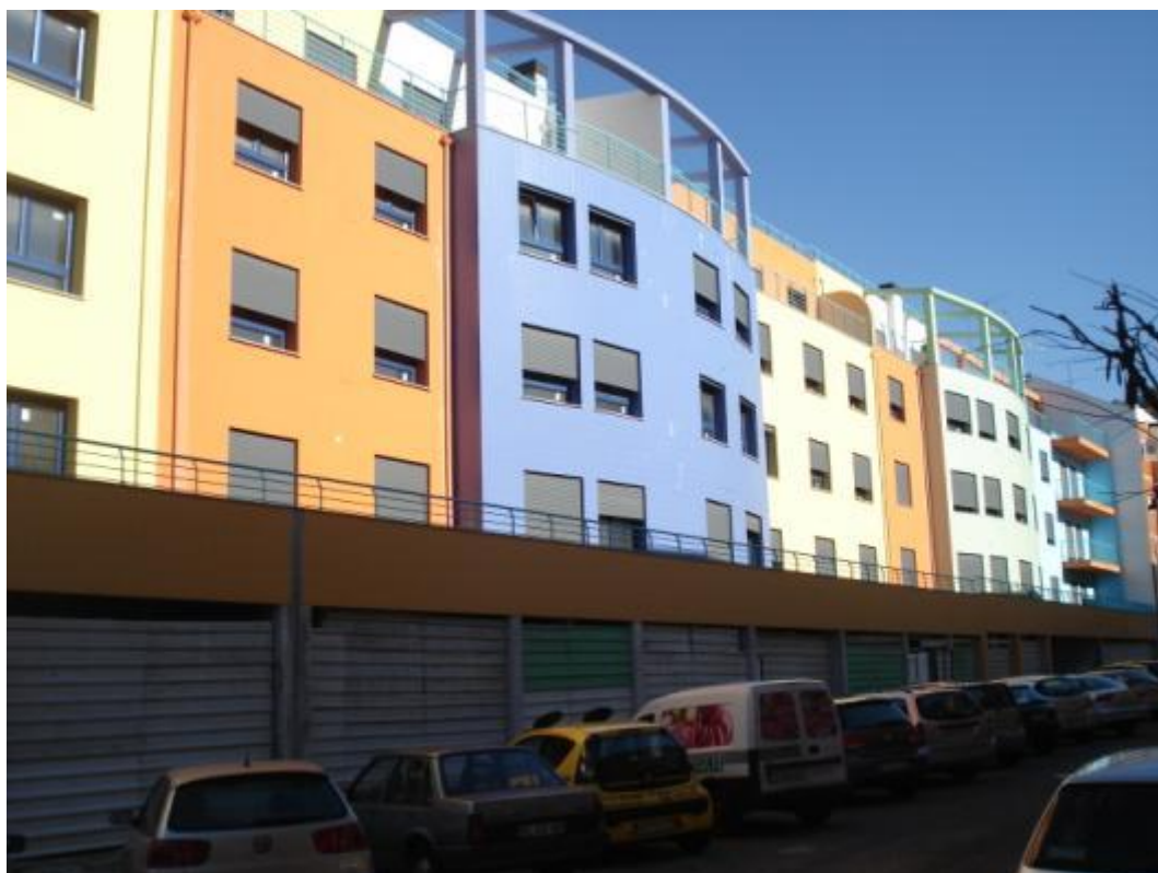
Figura 26 - Empreendimento imobiliário não concluído (Rua de Macau, Olival Basto)
