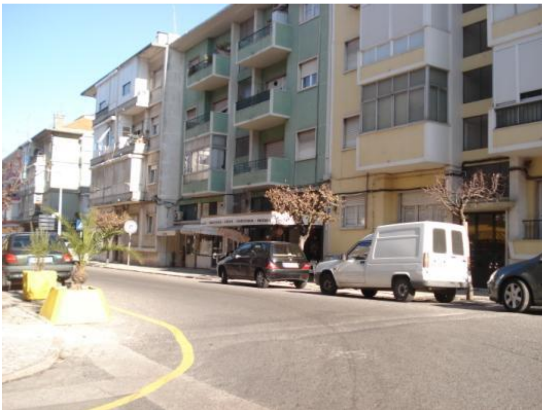
Figura 22 - Edifício típico do Olival Basto (Rua de Timor, Olival Basto)
