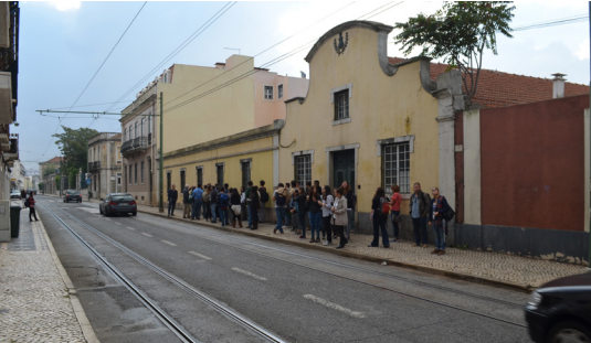
FACHADA DO ARMAZÉM NA RUA DA JUNQUEIRA
