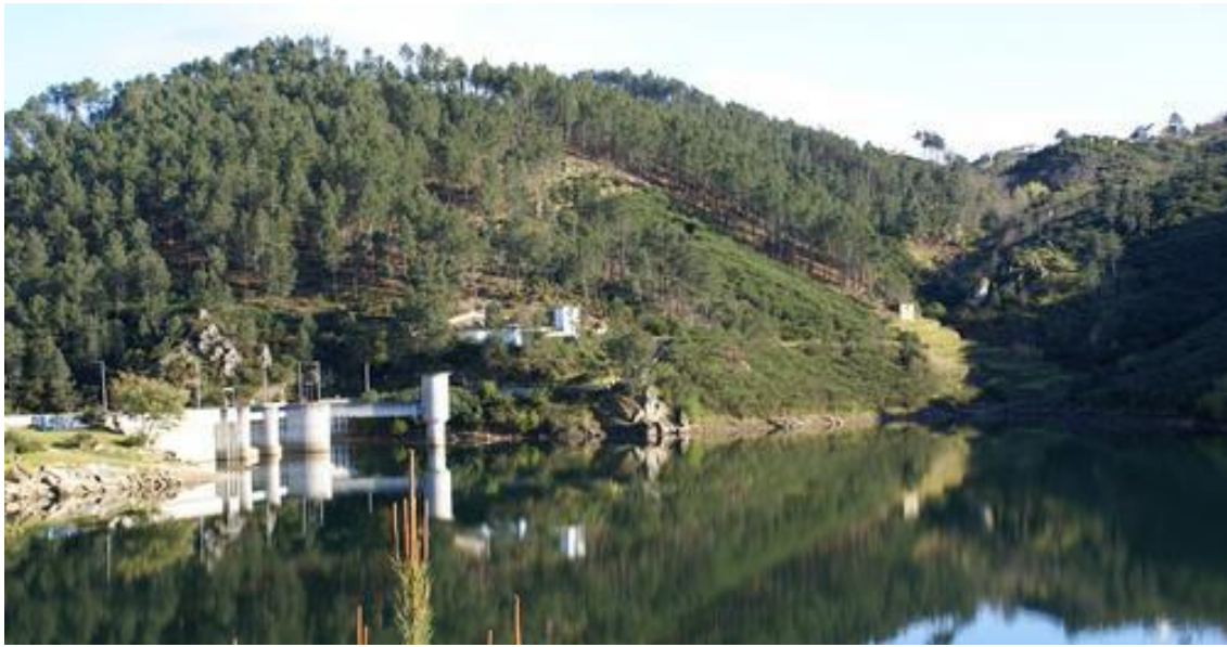
Figura 3.1. Barragem do Sordo (vista de montante). Fonte: [26]
