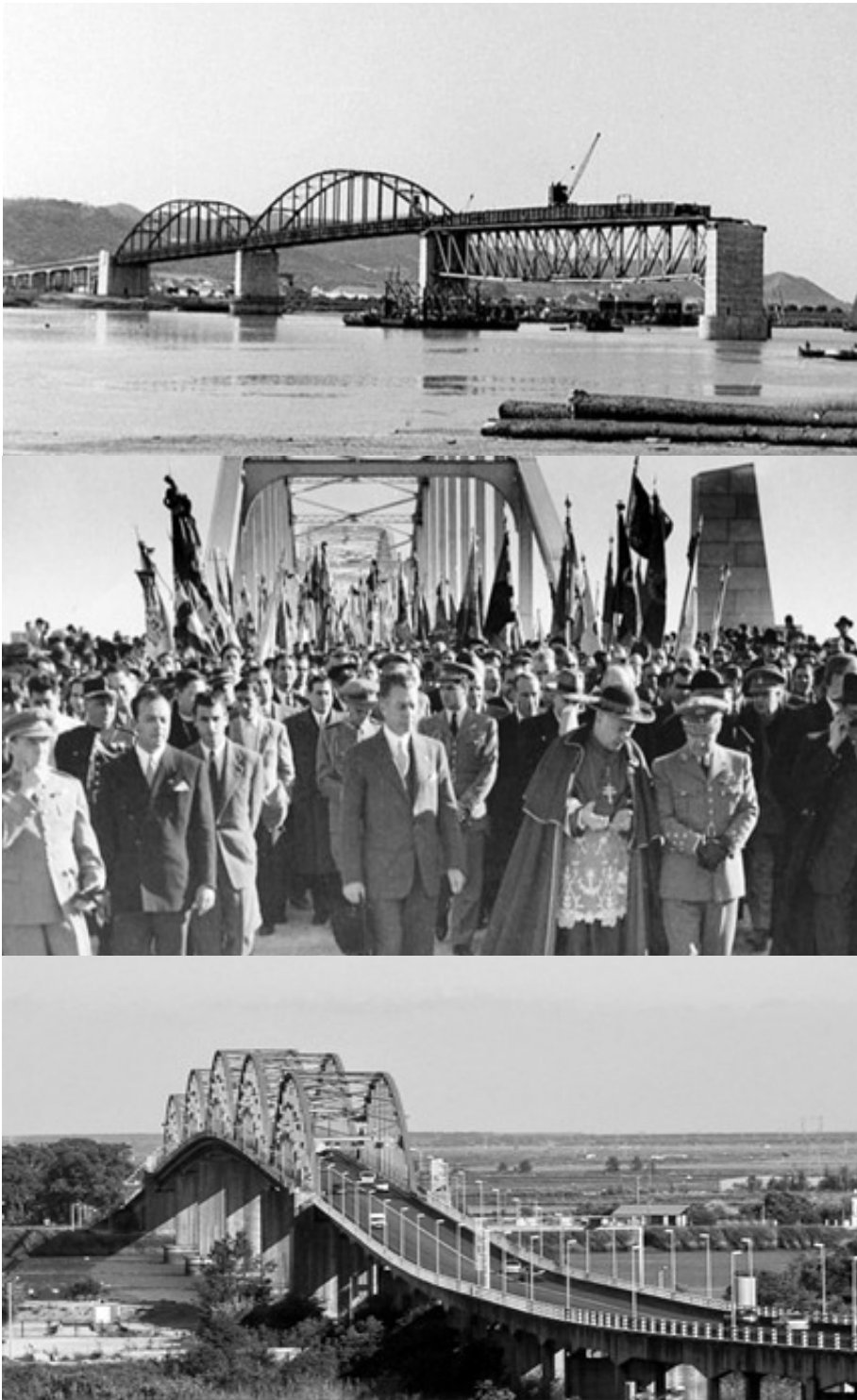
Figure 24 – Construção da Ponte Marechal Carmona, Vila Franca de Xira.
