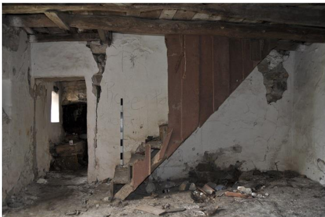
3 Caixa de escadas (casa de fora)
