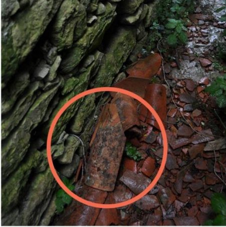
Amostra 9 | Telha | Edifício 3
