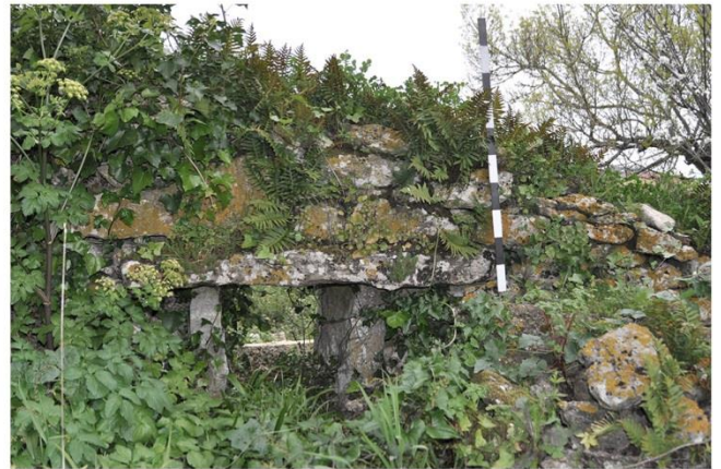
4 Vão para descarga
