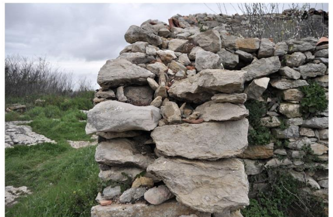
4 Parede de alvenaria de pedra
