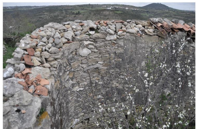
6 Parede de alvenaria de pedra
