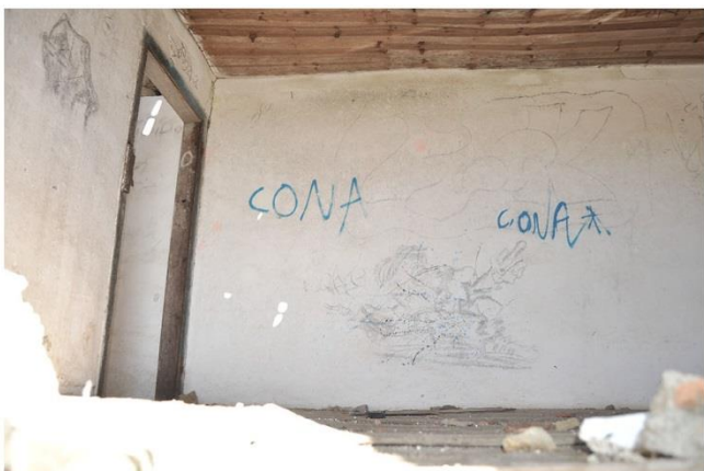
12 Quarto (primeiro piso, sobre a casa de fora)
