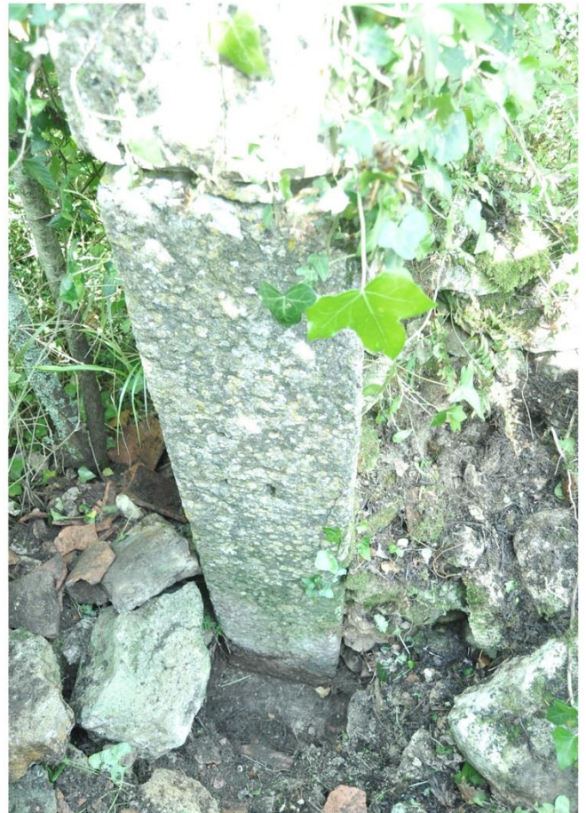
5 Ombreira (escavado até à soleira)
