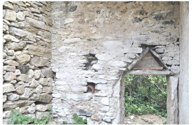
2 Arco de descarga em triângulo
