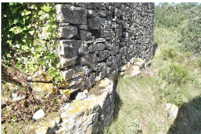
5 Alvenaria sobre rocha existente
