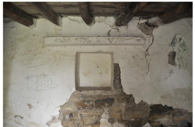
4 Buraca e Cantareira (casa de fora)
