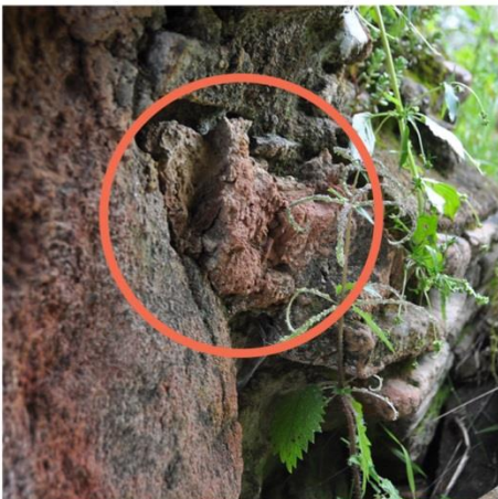
Amostra 8 | Argamassa do forno | Edifício 16
