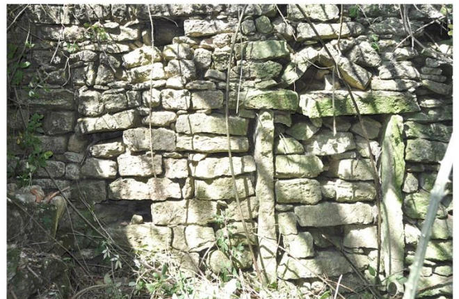
4 Porta entaipada (ligação com edifício 6)
