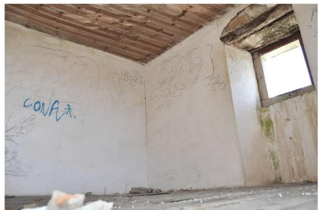
13 Quarto (primeiro piso, sobre a casa de fora)
