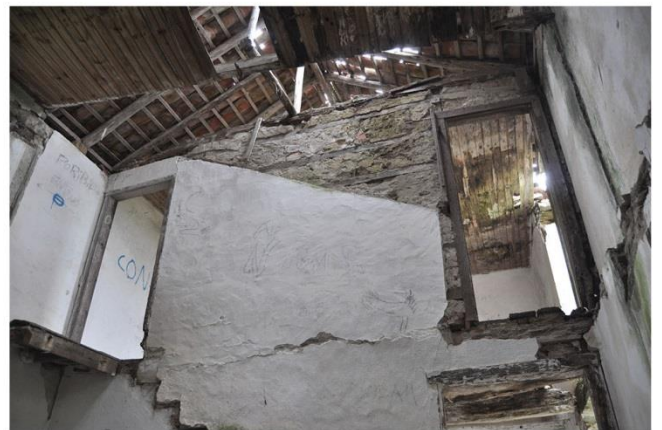
9 Parede entre os quartos, em tabique
