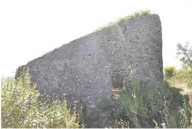
1 Exterior (vão de descarga)
