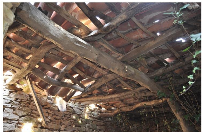
6 Madeiramento da cobertura
