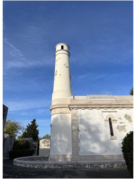
Fig. 14 – Chaminé do crematório
