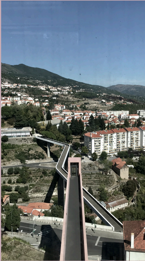
Fig4. Ponte Pedonal- Ribeira da Carpinteira, Covilhã
