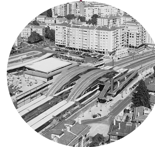
Passagem acesso à estação Massamá-Barcarena
