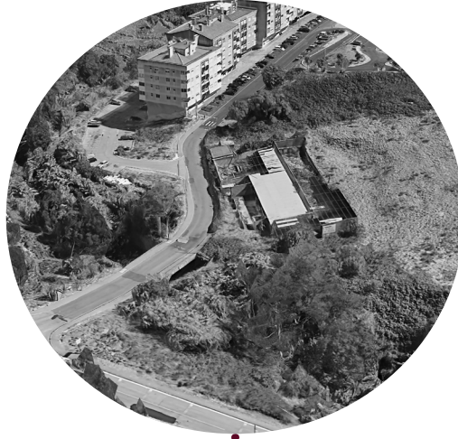
Passagem sobre a ribeira
