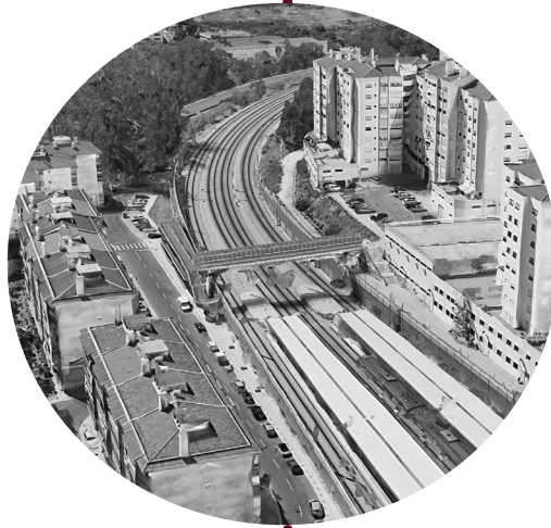
Passagem sobre a linha férrea
