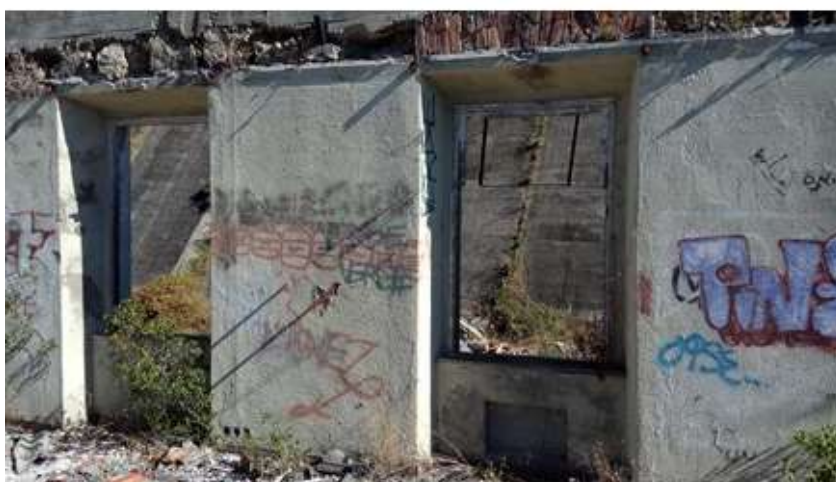
Imagem 00 131 Fotografia do interior do primeiro piso do edifício de intervenção. Fotografia da autora. Outubro 2016. (em cima, à esquerda).
