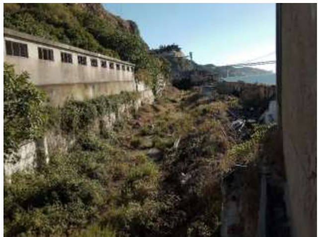
Imagem 00 54 Fotografia da vista de uma janela, sobre as ruínas no interior dos edifícios do Ginjal. Fotografia da autora. Junho 2018. (à direita)
