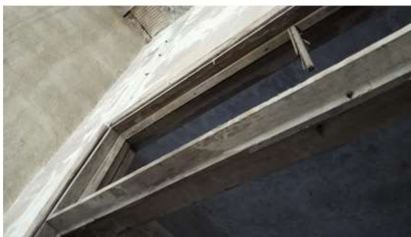
Imagem 00 116 Fotografia do interior do piso térreo do edifício de intervenção. Fotografia da autora. Outubro 2016. (em cima).
