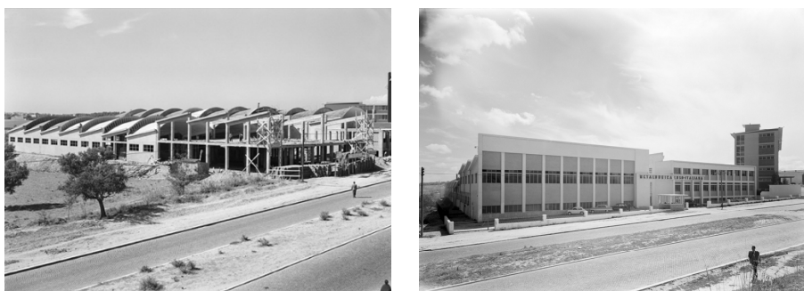
Figuras 24 e 25. À esquerda: Construção de pavilhão da Metalúrgica Luso-Italiana. À direita: Vista do complexo fabril na Avenida Marechal Gomes da Costa. Estúdio Mário Novais. Data de produção da fotografia original: finais dos anos 50. (FCG-BA, 2016).
