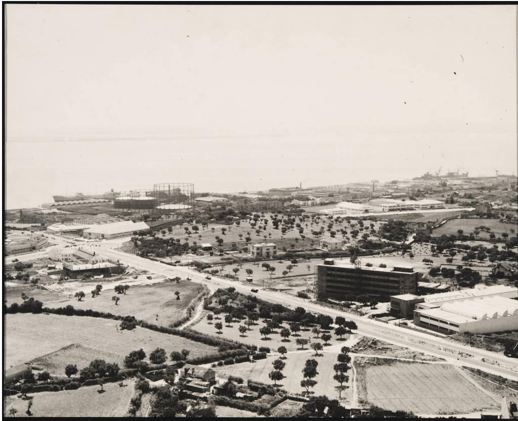
Figura 21. Fotografia aérea da zona de Cabo Ruivo, anos 50, Laboratórios Pasteur em construção. Sem identificação de autor. Arquivo Fotográfico Municipal de Lisboa, Departamento de Projeto e Planeamento. (AFML, 2016)
