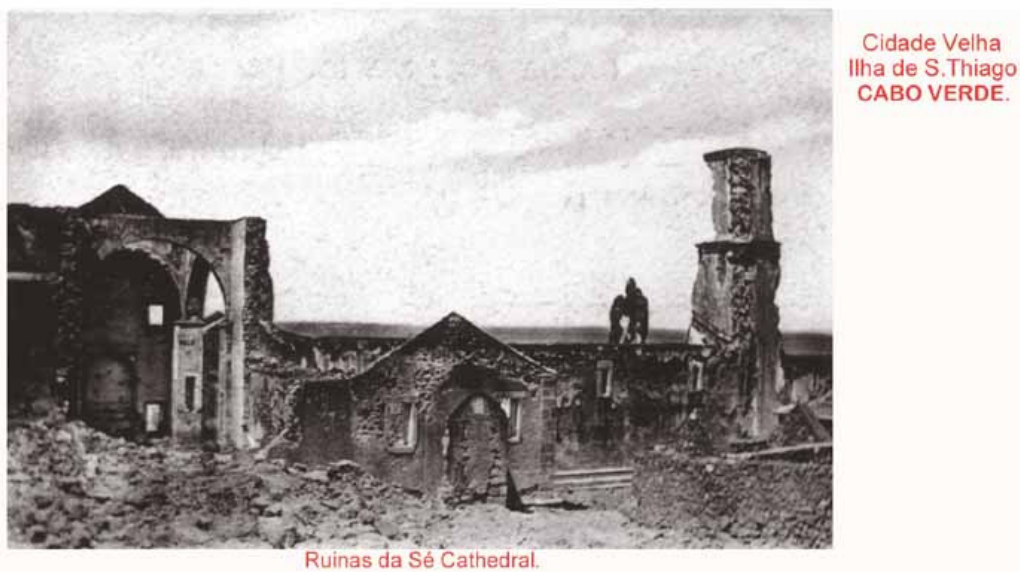
Fig. 9 Ruínas da Sé Cathedral - AHU
