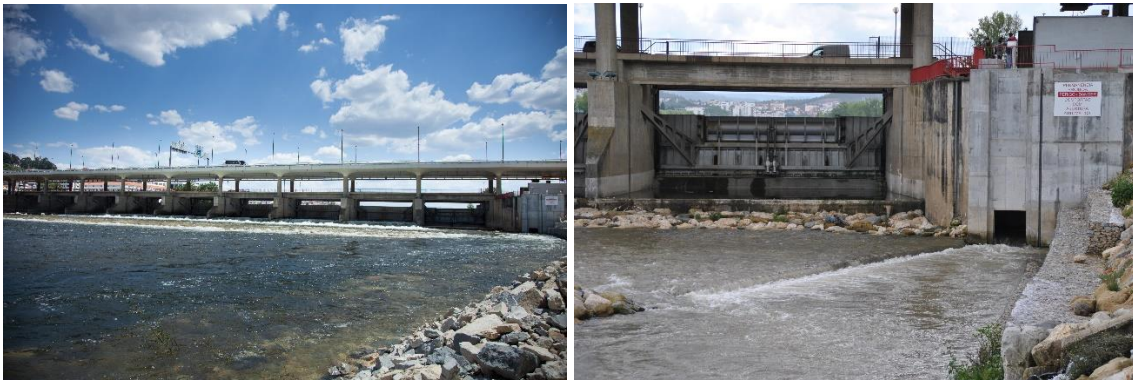
Figura 2.2. Açude-Ponte de Coimbra, na imagem da direita inclui-se pormenor da entrada da PPP multi-específica em funcionamento nesta infraestrutura.
