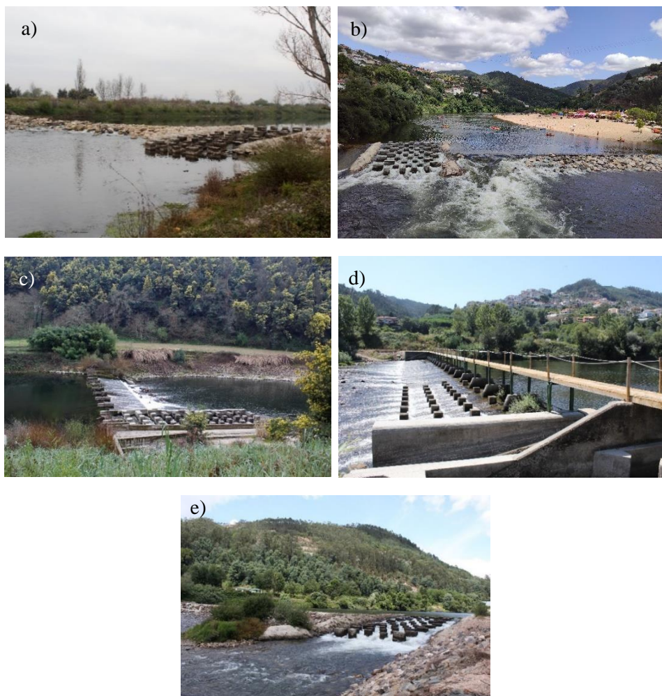
Figura 2.3. Passagens para peixes construídas em pequenos açudes no troço principal do rio Mondego: Açude de Formoselha (a), Palheiros (b), Louredo (c), Carvoeira (d), Penacova (e).
