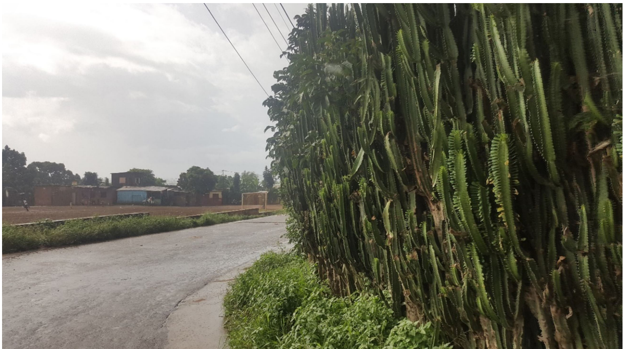
Figura 50 Foto da zona de intervenção, Bairro de Hospital (são Tomé)
