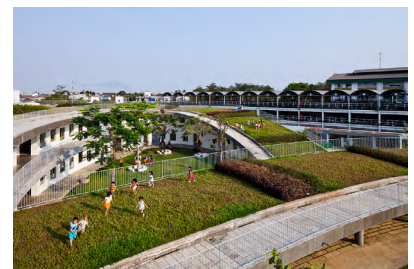
[114] Vista da cobertura
