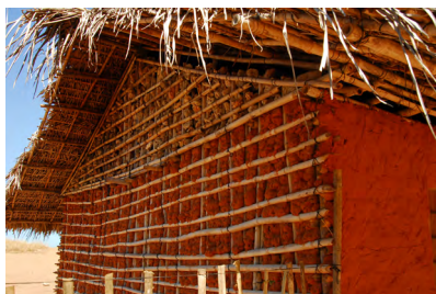
[147] Construção em pau a pique
