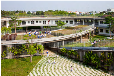
[117] Vista do exterior
