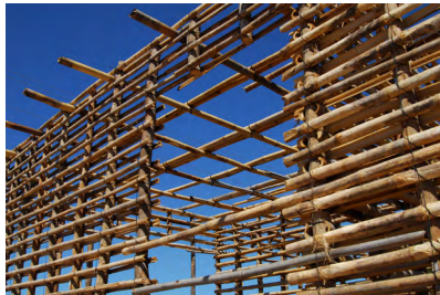
[146] Construção em pau a pique
