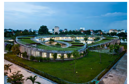
[113] Vista do exterior
