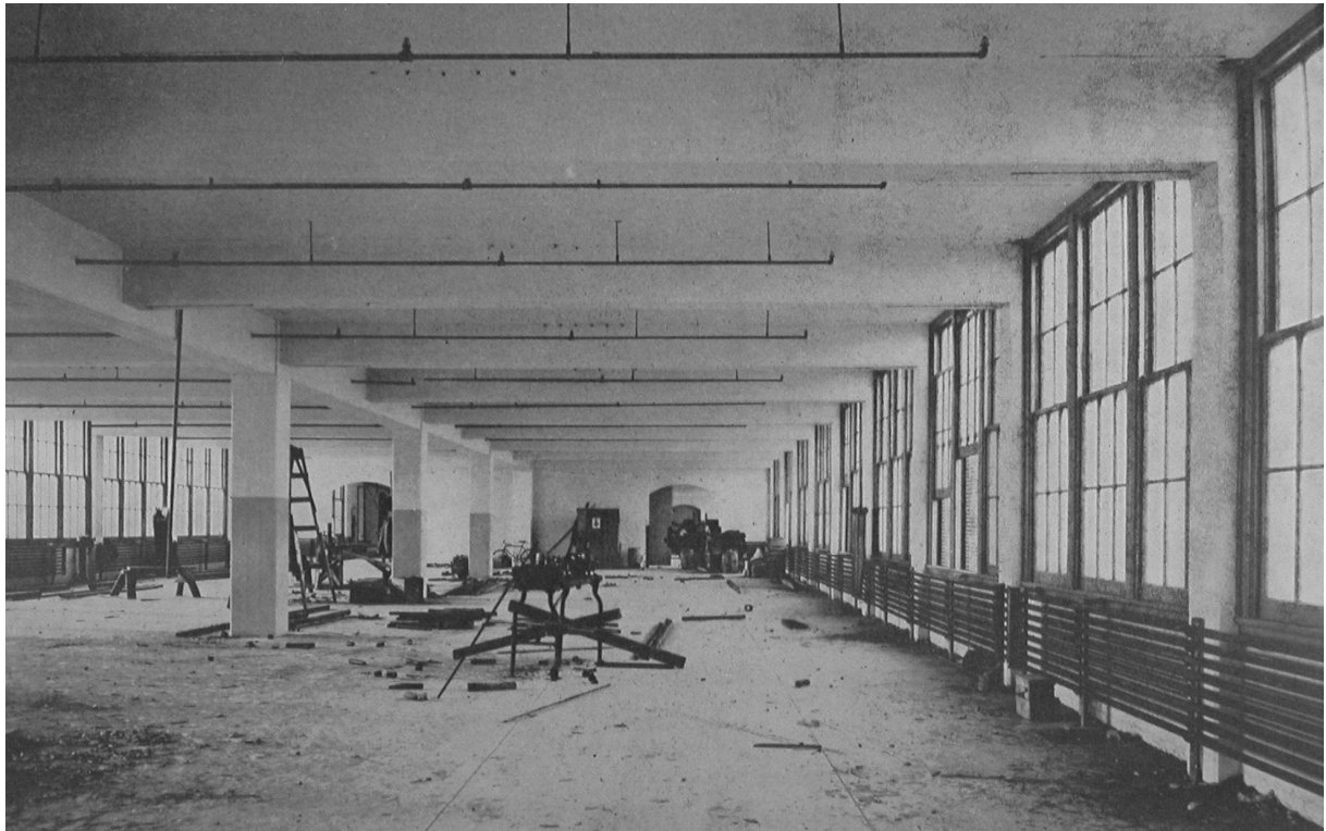
Fig. 5.27. O interior ainda livre de ocupação (in Atlas, 1907: 145). Note-se o sistema de sprinklers, as tintas de protecção pilares bem como o sistema de aquecimento junto aos vãos.
