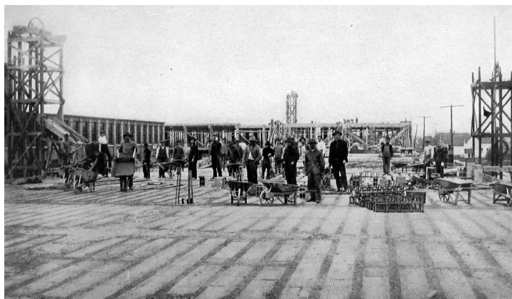
Fig. 5.22. Aspecto do pavimento de betão do piso 2 a ser construído (in Atlas, 1907: 139). É visível o desenho das vigas embutidas na laje, bem como a área ocupada pelos elementos cerâmicos de enchimento.
