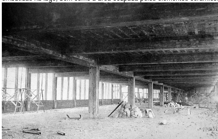
Fig. 5.23. Interior em obra (in Atlas, 1907: 140). Note-se a relação das lajes com a fachada e elementos vitrais acentuando um efeito da construção laminar da estrutura.
