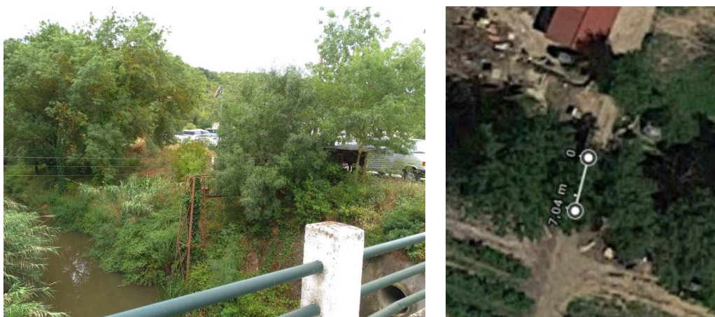
Figura 3.9 – a) Estação Ponte Barnabé (19C/02); b) Zona da estação Ponte Ota (19D/04).
