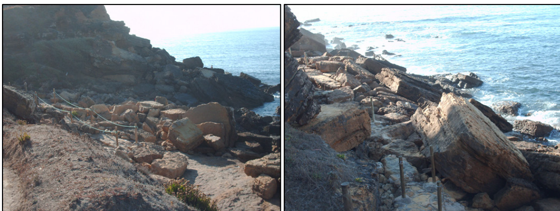
Figura 1.1 – Acesso pedonal junto à base da arriba, a Sul da Praia de São Lourenço. O caminho encontra-se muito destruído, sendo um risco a circulação de humanos. Fotografias de Agosto de 2011.
