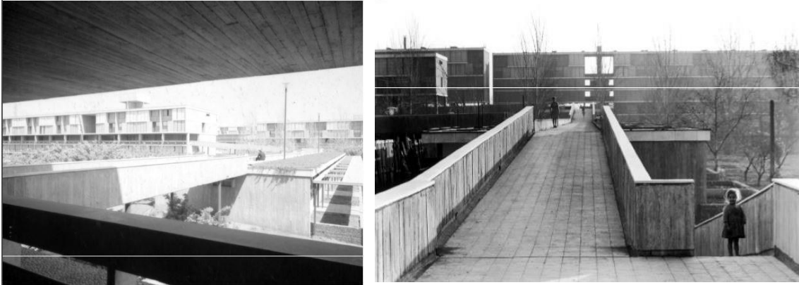
Fig. 7 Vista dos sistemas de circulações presentes no conjunto habitacional
