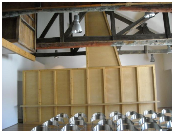
Figura 83 - CAV-sala de conferências, lanternim existente e lanternim novo que ilumina as escadas de acesso ao piso inferior [35]
