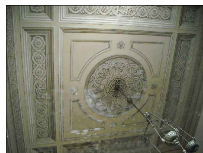
Tecto Hall de entrada
