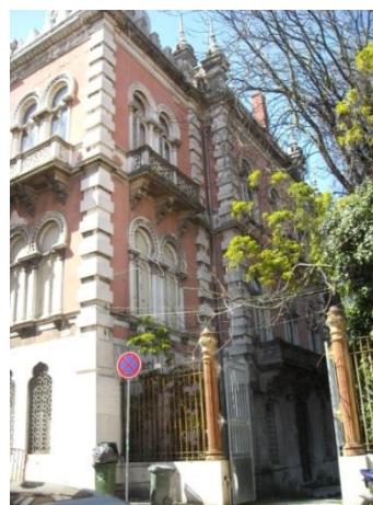
Figura 2 - Palacete Ribeiro da Cunha-Alçado Norte [1]
