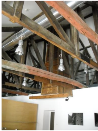
Figura 84 - CAV-sala de conferências – lanternim existente [35]
