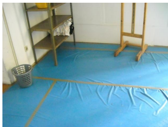
Figura 45 - Cooperativa Árvore-pavimento da sala de pintura [16]
