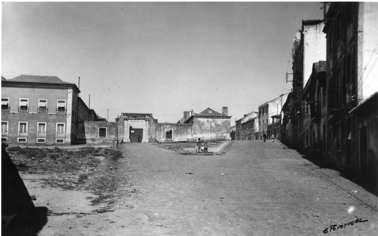
Fig. 89 – Existem três chaminés na fachada norte e uma na fachada poente, correspondendo às quatro salamandras. Arquivo Municipal de Lisboa PT/AMLSB/POR/057264. S.d.
