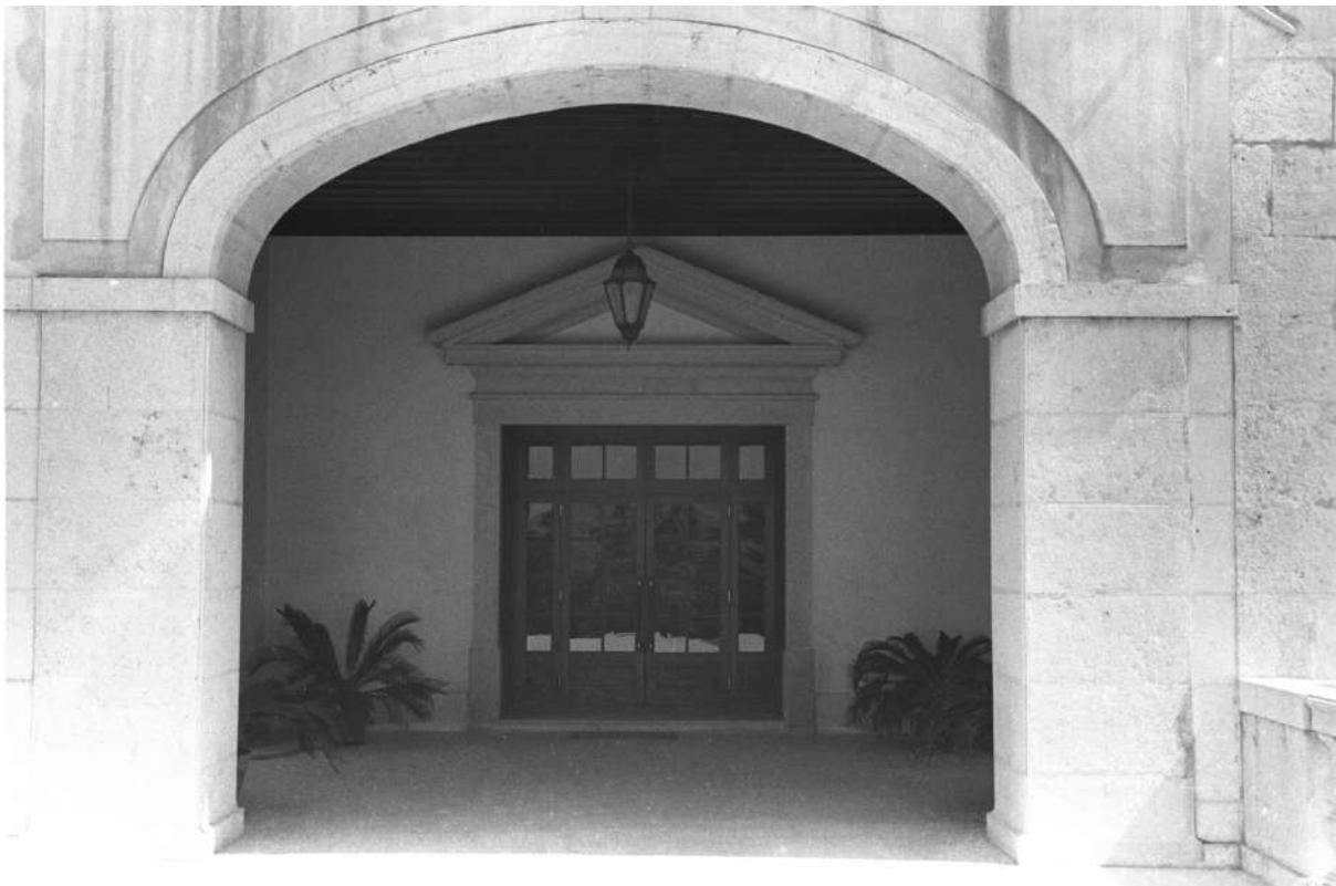
Fig. 95 – Arco de volta abatida, entrada principal e Frontão. UL-IICT-Col.FOTO-JBT_25872. S.d.
