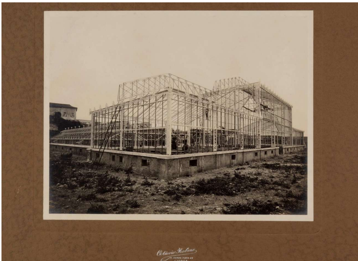
Fig. 79 – Construção da Estufa Principal (1913-1914). No canto superior esquerdo, ao fundo, é possível observar o estado de degradação exterior do palácio. Cota: UL-IICT-Col.FOTO-JBT_22071.
