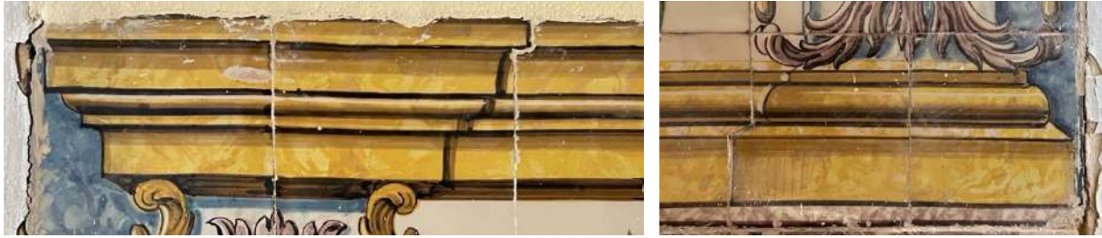
Fig. 70 – Sala LX_BL_PCC_06, detalhe do corte de alguns azulejos.
