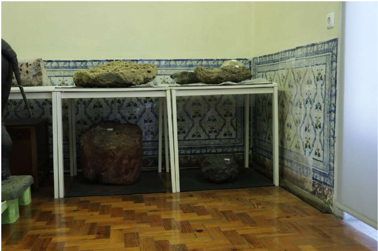
Fig. 130 – Sala LX_BL_PCC_03, parede 2, seção 1, com parte dos padrões pintados, procurando simular o restante revestimento.
