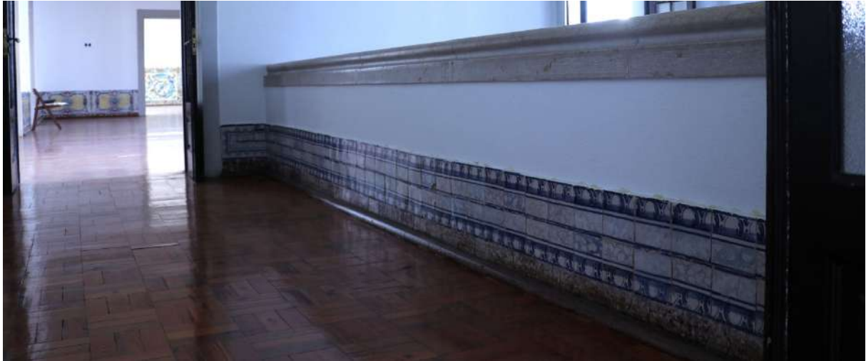
Fig. 135 – Corredor LX_BL_PCC_13, parede 3.
