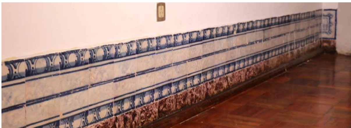
Fig. 123 – Corredor LX_BL_PCC_13, parede 1, seção 1.
