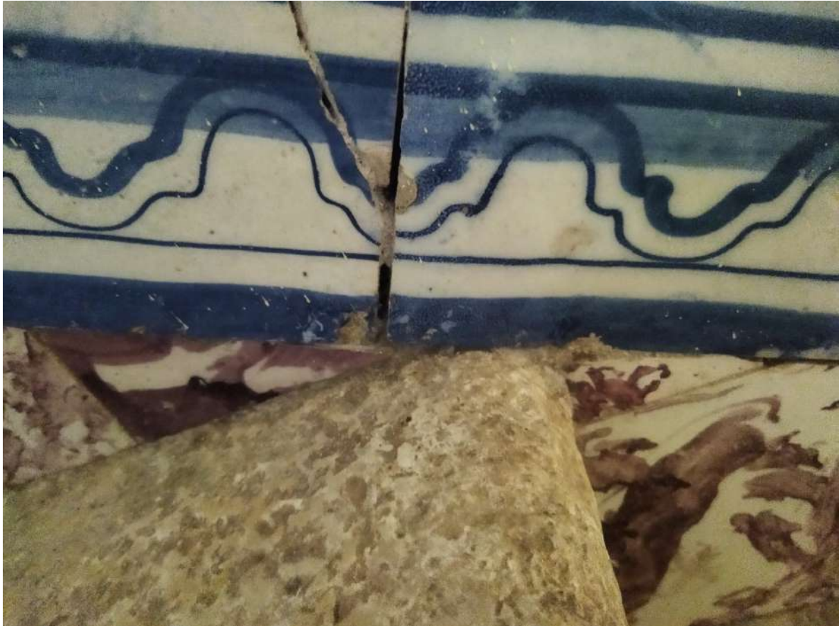
Fig. 126 – Escadaria LX_BL_PCC_14, detalhe que torna visível a forma como os azulejos assentam sobre os degraus.
