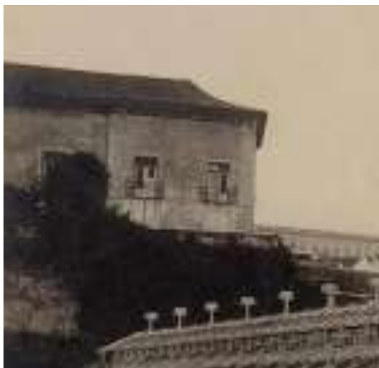
Fig. 81 – Detalhe da Fig. 79, destacando o palácio.
