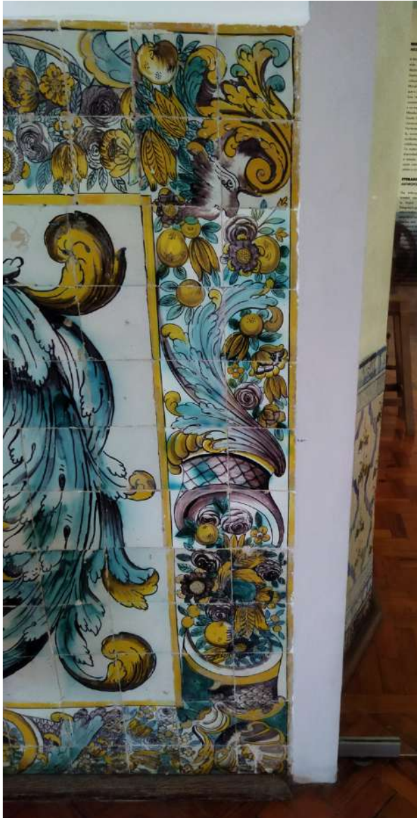
Fig. 120 – Sala LX_BL_PCC_02, parede 03, com a barra inferior e lateral direita danificadas e posteriormente restauradas aquando do fecho da reentrância.
