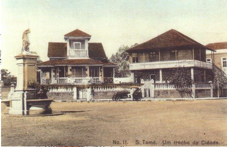
Figura 44 – UM TRECHO DA CIDADE – RUA DA MISERICÓRDIA Fonte: http://stparquitecturarte.blogspot.pt/2009_11_15_archive.html
