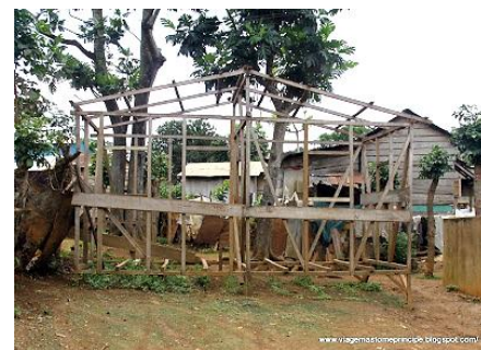
Figura 70 – ESTRUTURA PARA CONSTRUÇÃO DE UMA HABITAÇÃO FONTE: http://viagemastomeprincipe.blogspot.com/
