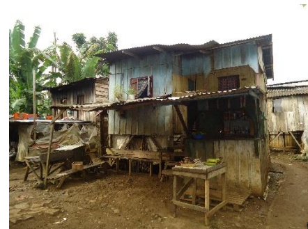
Figura 57 – EXEMPLO DE HABITAÇÃO CONSTRUÍDA EM MADEIRA
