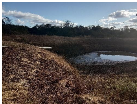
Figura 55 - Lagoa de decantação
