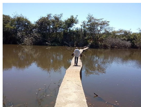
Figura 14- Muro de separação da barragem nº1 e nº2
