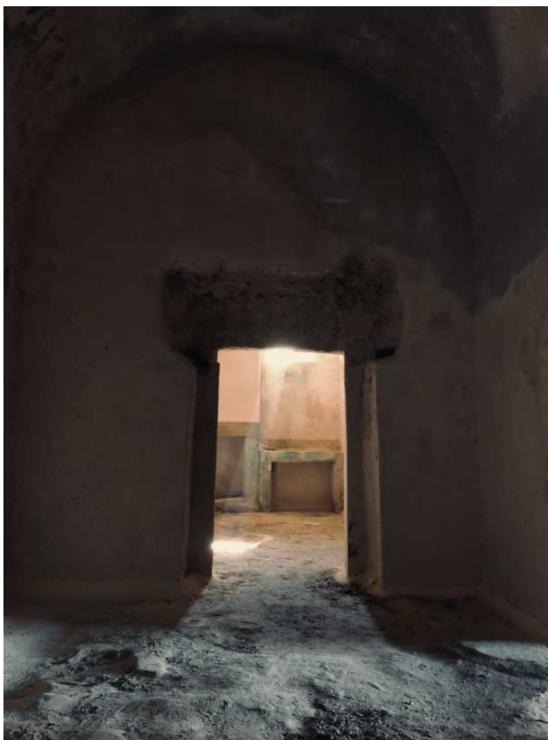
70. Interior, primeiro piso do Forte do Pessegueiro. Ana Carolina Pereira, 2019
